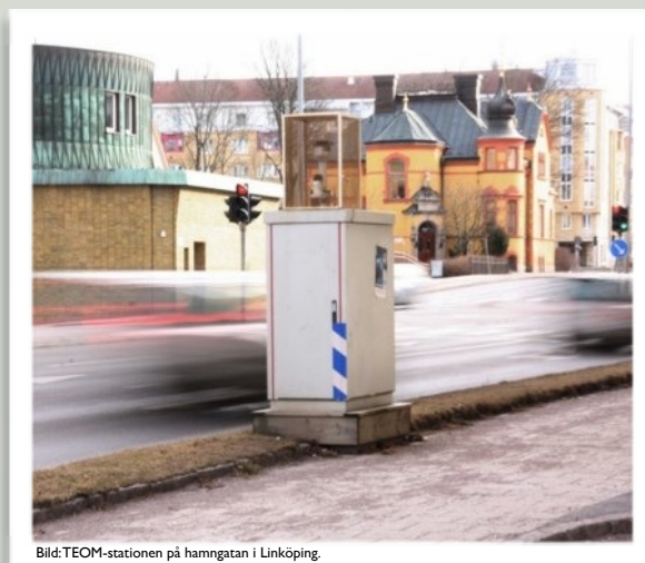
Bild: TEOM-stationen på hamngatan i Linköping.
